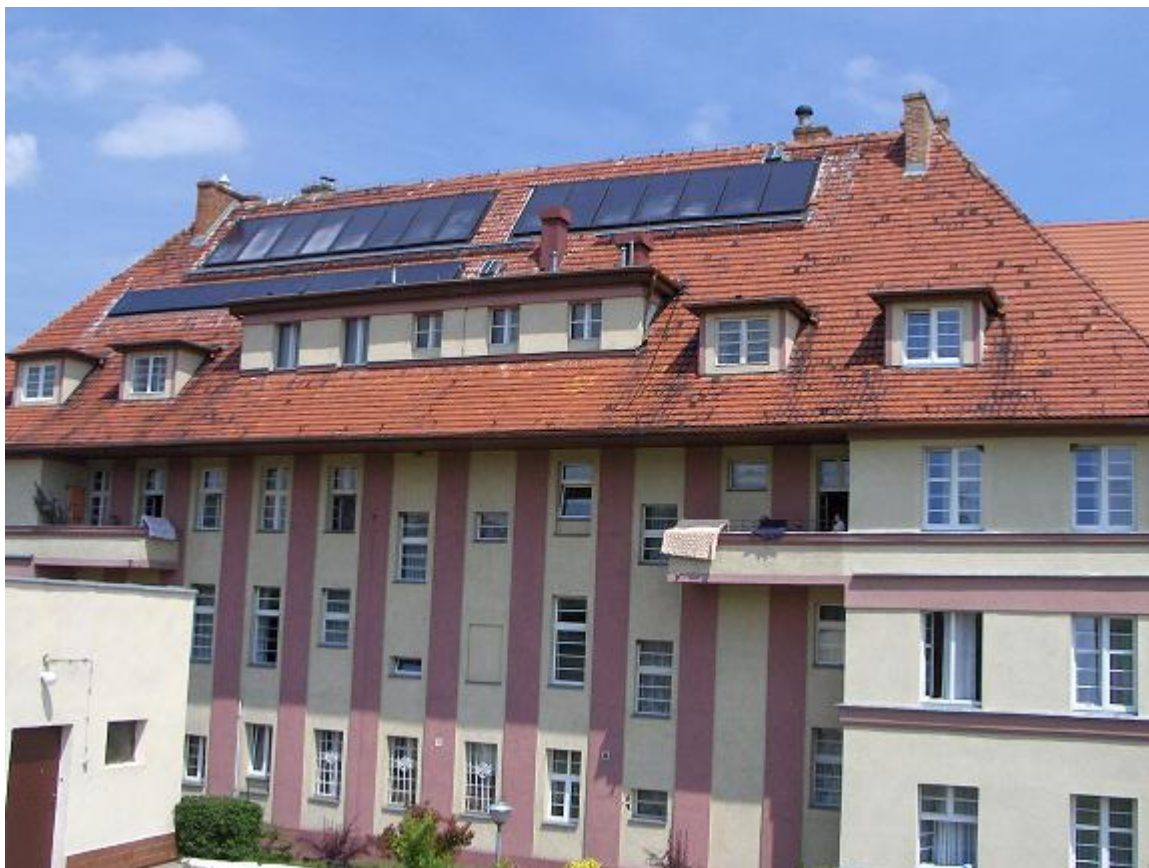
Rysunek 2-20 Instalacja kolektorów słonecznych na terenie Domu Dziecka w Niemczy
