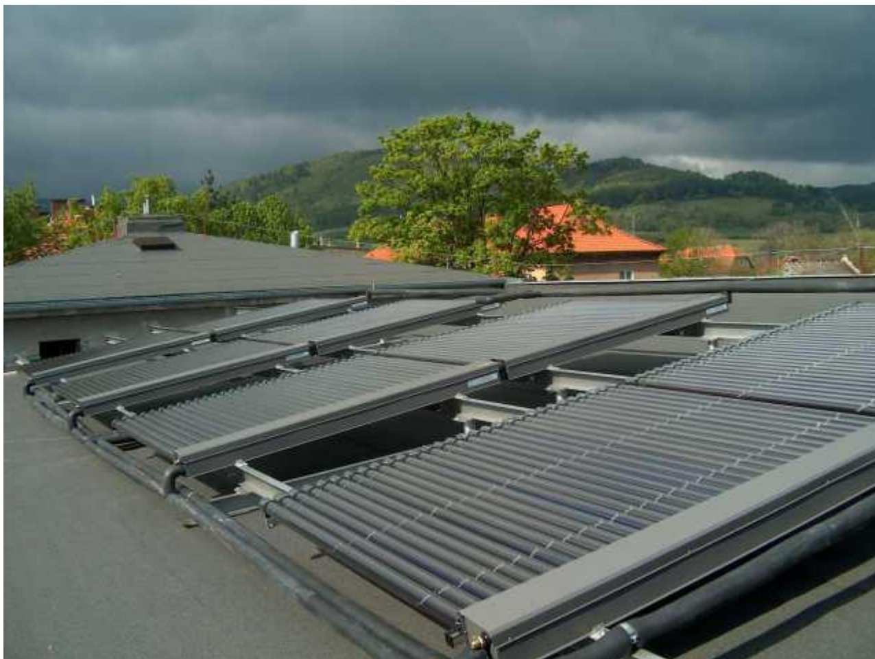
Rysunek 2-21 Instalacja kolektorów słonecznych na terenie Domu Dziecka w Pieszcach
